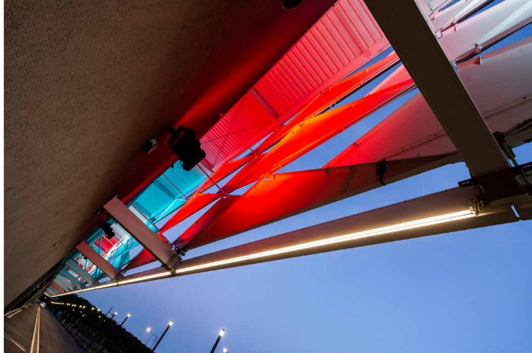
LED-Leuchten mit drei Optiken wurden jeweils am Mittelpunkt zweier Konstruktionsachsen installiert. Diese setzen die Membranfassade durch verschiedene Beleuchtungsoptionen in Szene. Die Beleuchtung der Fassade erfolgt von der Innenseite, womit die räumliche Tiefe und plastische Gestaltungsweise der Fassadenkonstruktion betont wird.
