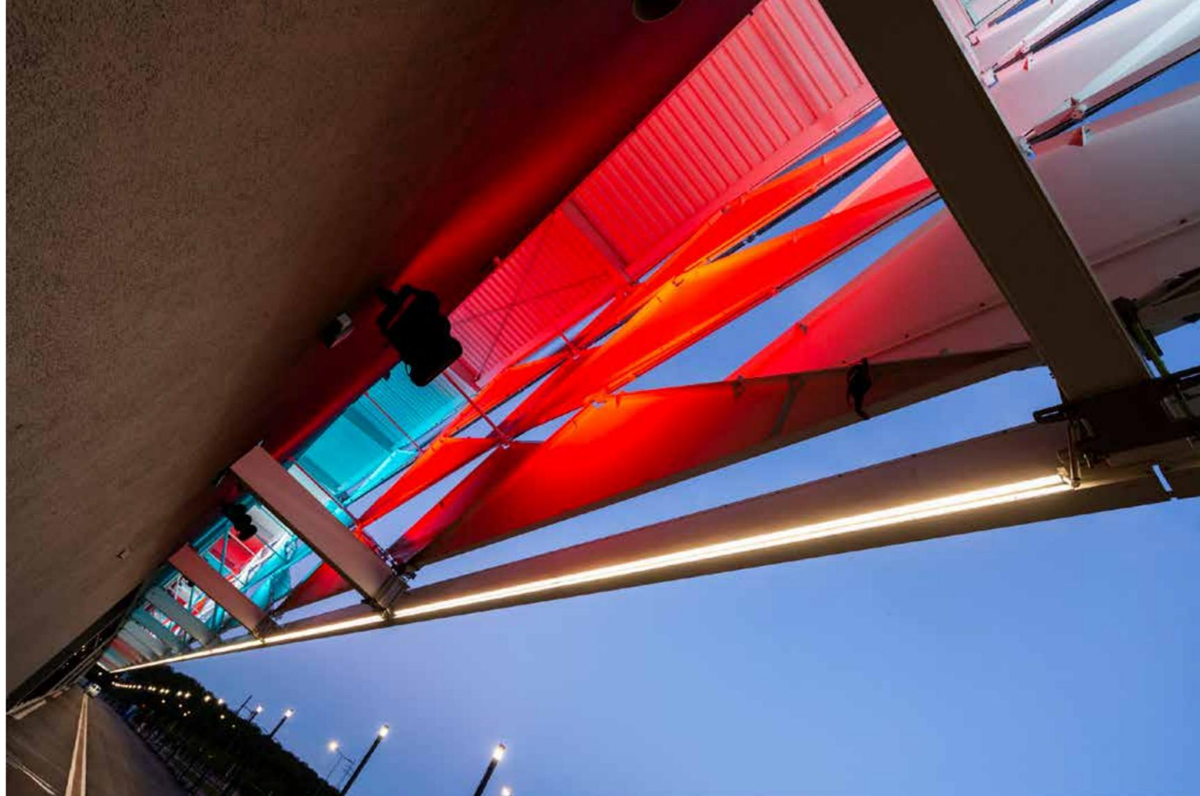
Un éclairage scénique de la façade haubanée aux scénarios variés est désormais possible grâce à la mise en place de luminaires LED à 3 optiques au milieu de chaque axe constructif. La façade est éclairée depuis la face intérieure, permettant ainsi de renforcer davantage la profondeur et la plasticité de son principe constructif.
