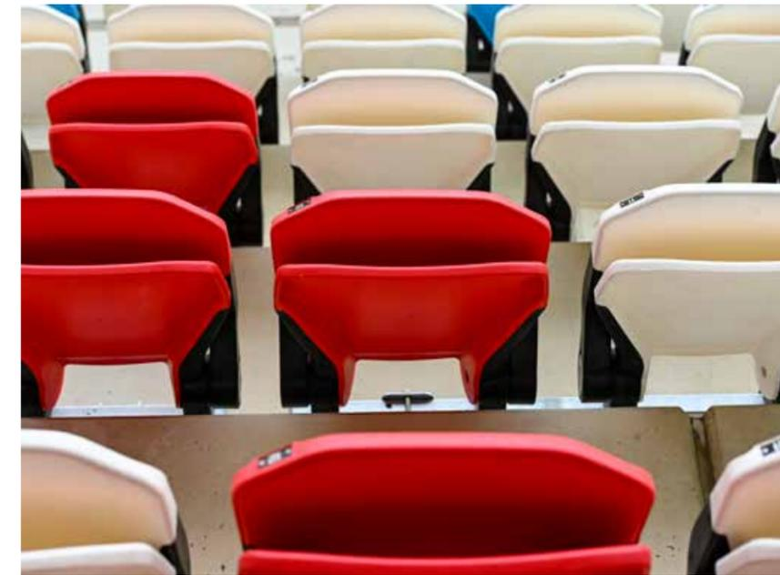
Les tribunes, construites en éléments de béton préfabriqué, sont équipées de sièges rabattables de couleurs variées, rappelant les couleurs du drapeau luxembourgeois. Une déclinaison progressive du rouge foncé au bleu foncé crée un mouvement de vague dynamique.
